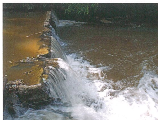
Figure 5 : photographie du seuil du Moulin Vert (G. Flucher, Inrap)
