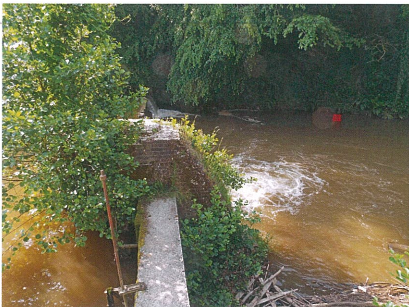
Figure 15 : photographie du seuil du « Moulin vert » (G. Flucher ; Inrap)
